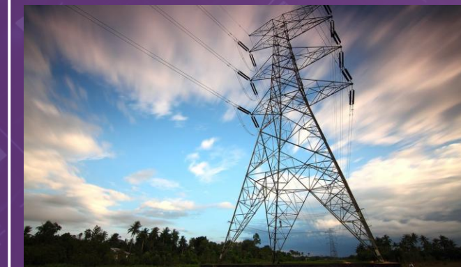
Bekalan elektrik yang stabil dan mencukupi
