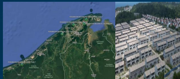
Meningkatkan Penyediaan Perumahan -Perumahan Negara Kampung Tanah Jambu Fasa 7
