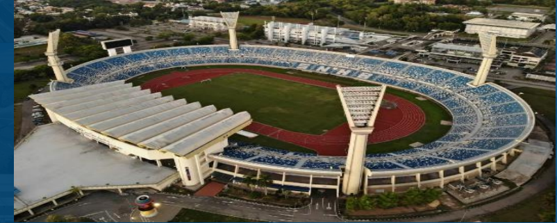
MENAIKTARAF STADIUM NEGARA HASSANAL BOLKIAH FASA 2
