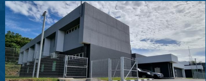
KOMPLEKS RUMAH KEBAJIKAN PERLINDUNGAN, KAMPONG BELIMBING, SUBOK
